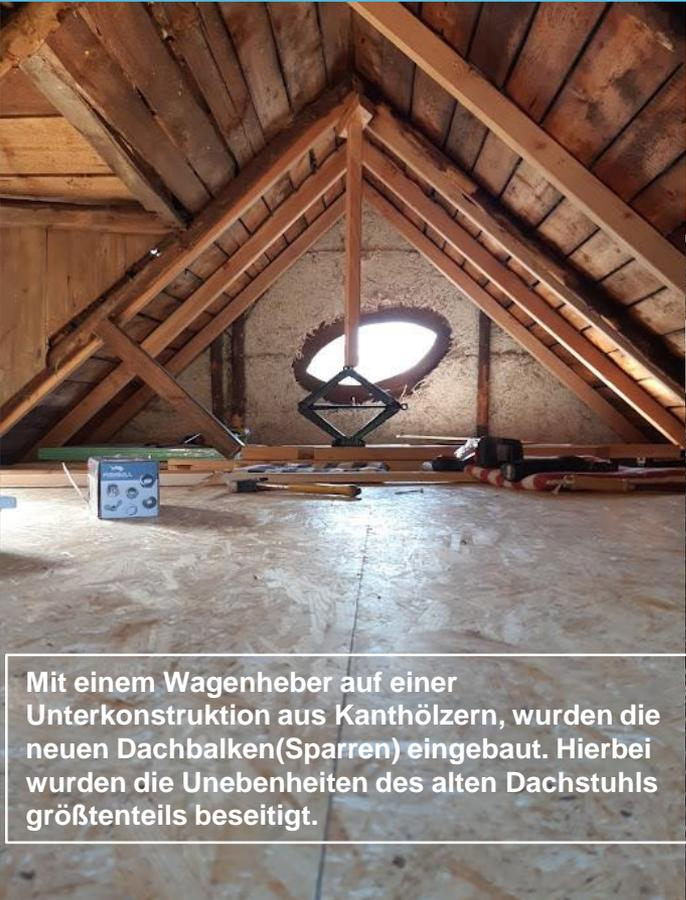
Mit einem Wagenheber auf einer Unterkonstruktion aus Kanthölzern, wurden die neuen Dachbalken(Sparren) eingebaut. Hierbei wurden die Unebenheiten des alten Dachstuhls größtenteils beseitigt.
