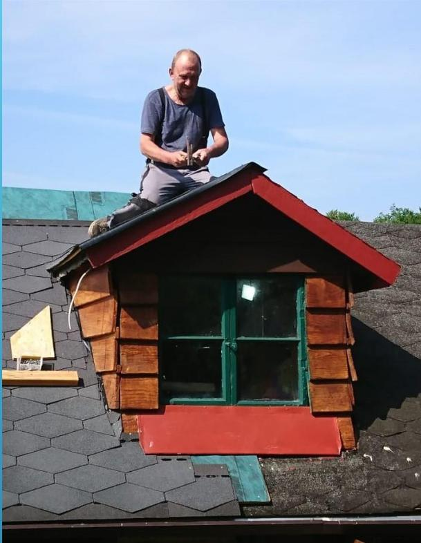
Die Unterspannbahn und Dachschindeln sorgen für die Dichtigkeit und erhalten die ursprüngliche Ansicht
