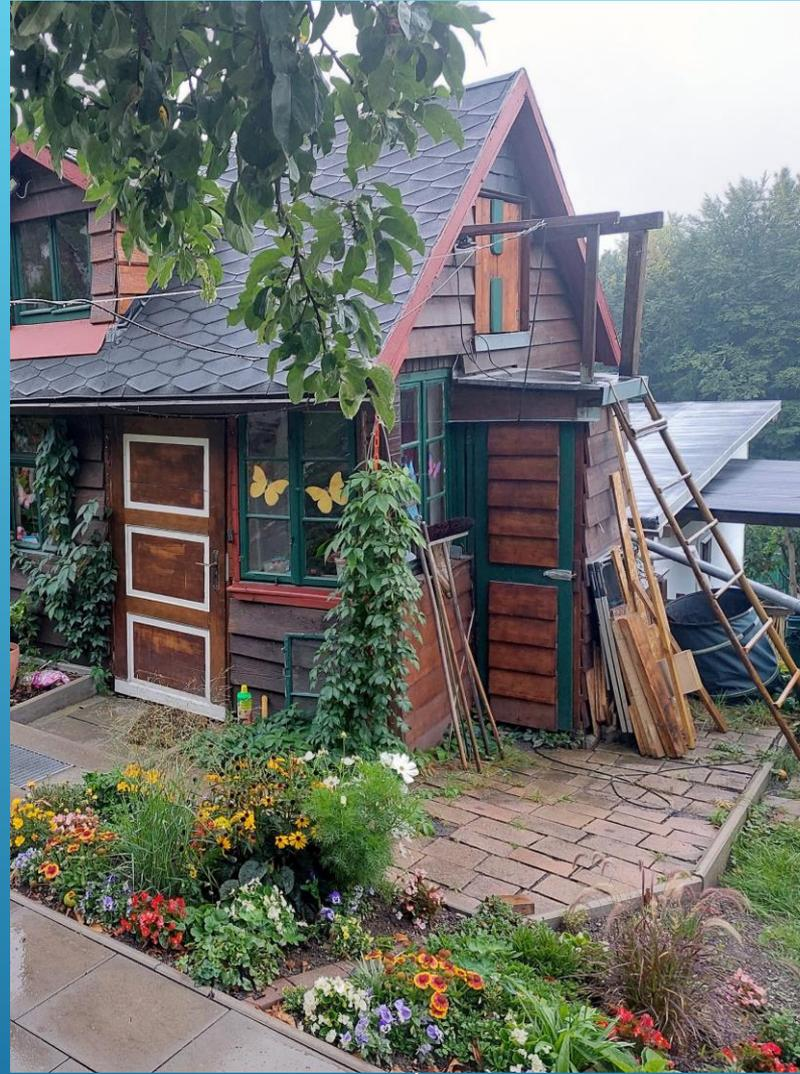
Undichte Stellen in der Dachhaut(6 Schichten Dachpappe und Schindeln) machten auch hier Reparaturarbeiten unumgänglich. Bei näherer Betrachtung des Dachstuhls der aus Rundhölzern(Baumstämm(ch)en) von maximal 7cm Durchmesser bestand, war schnell klar, dass an eine Reparatur von außen aus Sicherheitsgründen nicht zu denken war.
