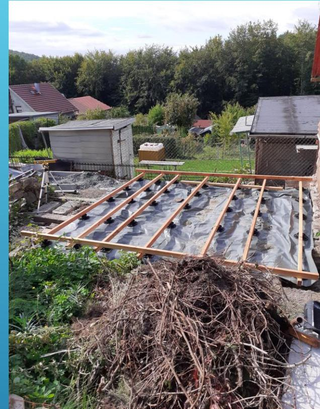
Verstellbare Stelzlager tragen die Längsträger der Unterkonstruktion. Die Folie verhindert das Wachstum von Unkraut.
